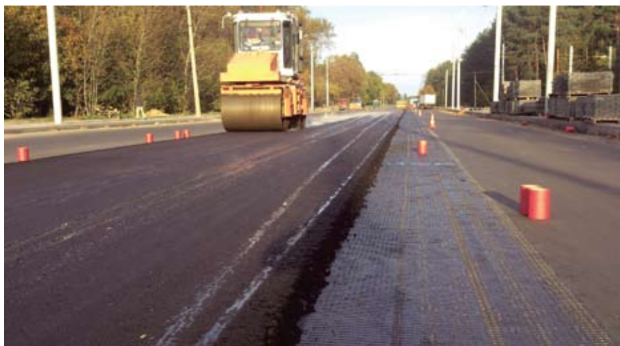
Устройство дорожного покрытия с применением геосетки
